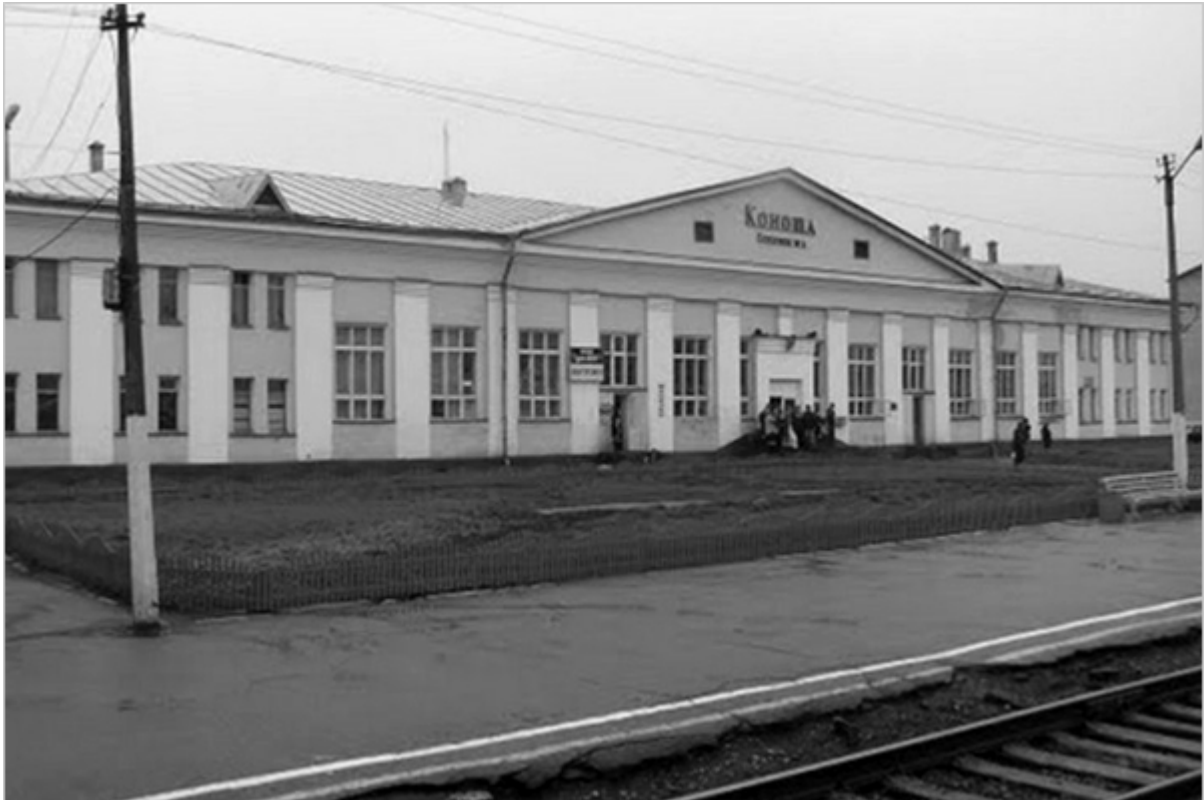
Konosa övergångsstation på linjen Arkangel-Vovogda (foto: sotahistoristellestkehte.fi)
